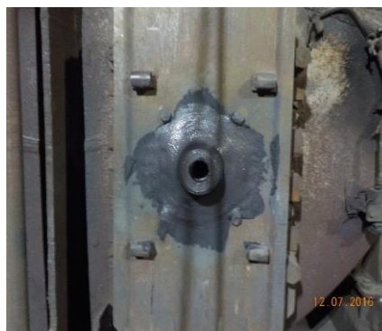
Fig.6. Orificiul Colector după montare
