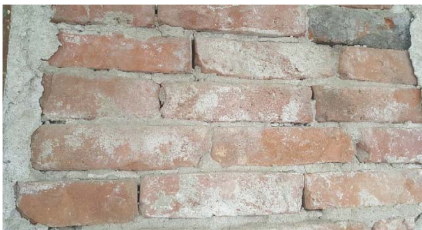
Fig. 1. Perete exterior din clădire
