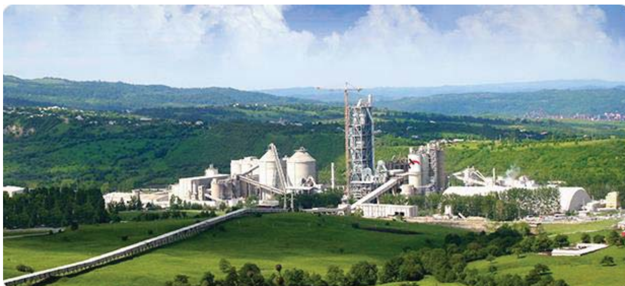
Fig. 1 Punct de lucru Ciment Câmpulung
