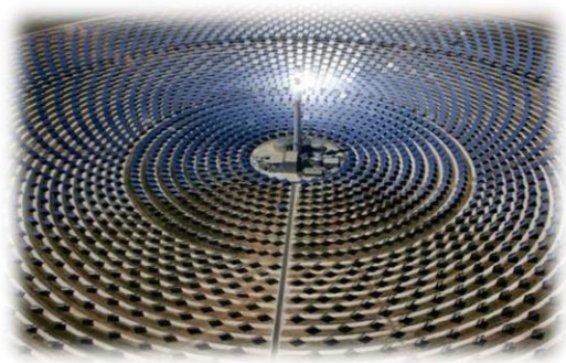
Fig. 12.a Centrală solară cu oglinzi aranjate sub formă de spirală
