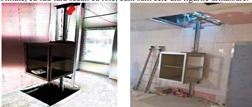
Fig. 1. Lift aprovizionare prin pardoseală ( https://www.google.com/search?q=lift+aprovizionare )
