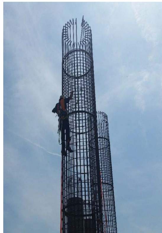
Fig. 11. Armarea carcasei stâlpului
