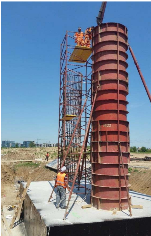
Fig. 10. Cofrarea și turnarea betonului în stâlpi
