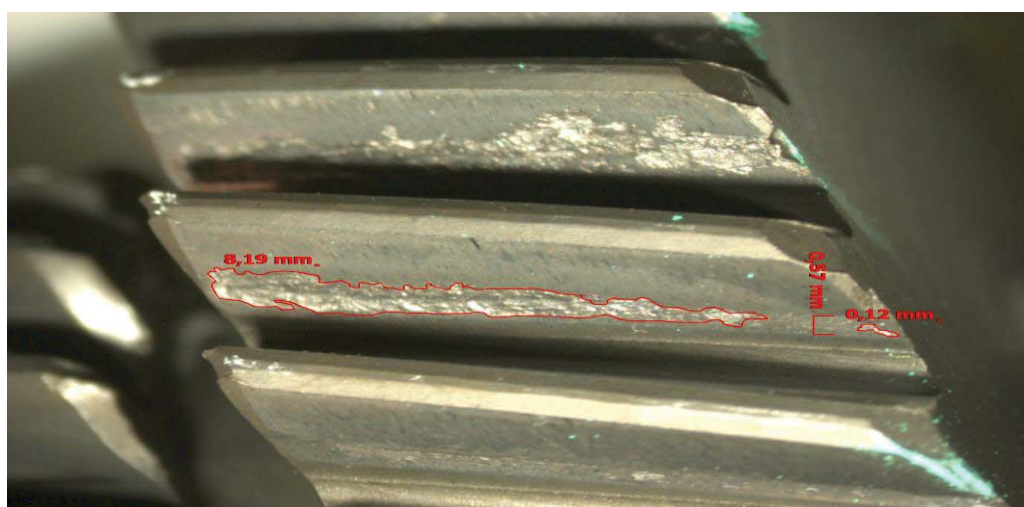
Fig. 4 – Zona de uzură de pe flancul dintelui
