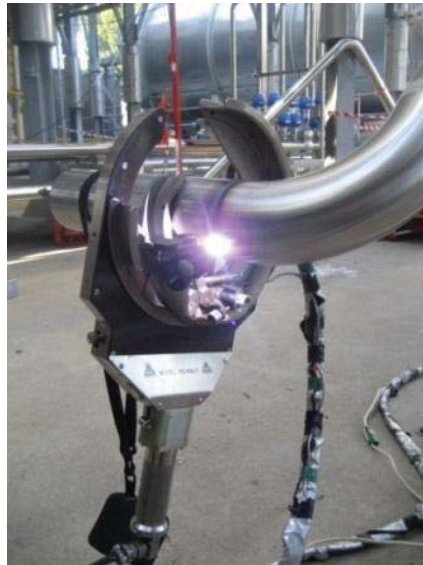
Fig. 2. Sudarea orbitală a unor componente de sudat fixe folosind un cap deschis
