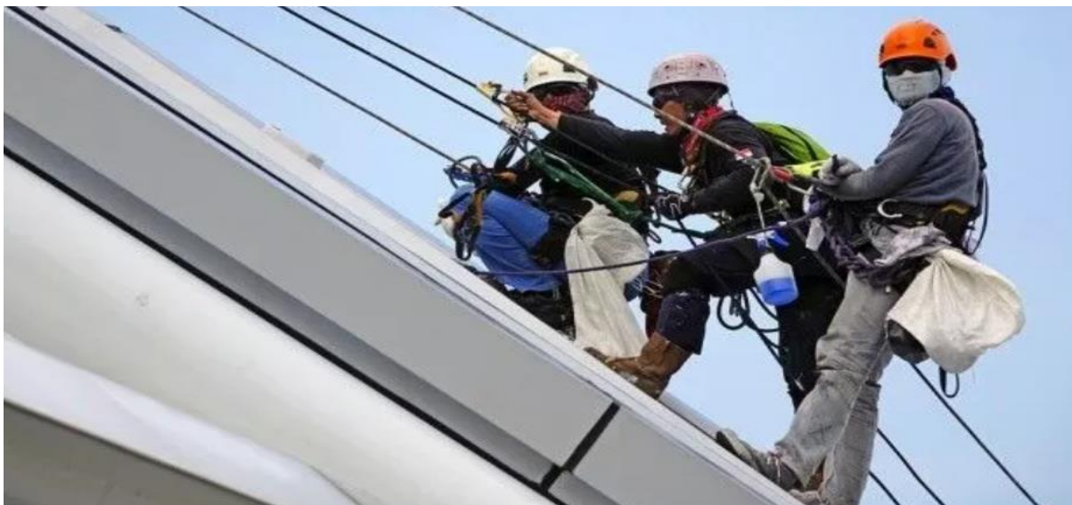
Fig.3.Centura complexa tip ham, linia vietii, opritoare de cadere
