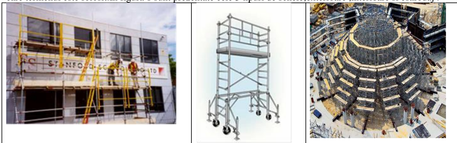
Fig.1 Schela exterioră, interioară și eșafodaj [cfm manual 1]
